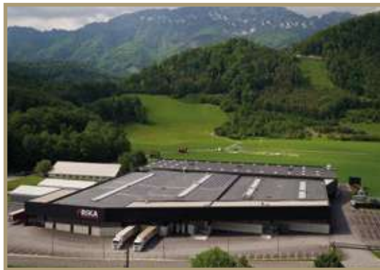
RIKA Entreprise de Métallurgie
